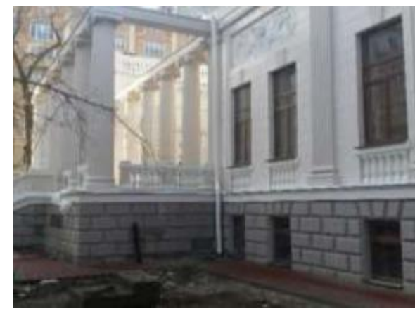
Объект культурного наследия федерального значения «Особняк Парамонова, нач. XX в.» (здание ЗНБ им. Ю.А. Жданова, г. Ростов-на-Дону, ул. Пушкинская, 148) Стоимость выполненных работ : 12 219, 1 тыс. руб.
