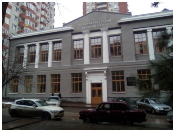
Объект культурного наследия регионального значения «Здание городского училища им. Е.Т. Парамонова» (СКНЦ ВШ ЮФУ, г. Ростов-на-Дону, ул. Пушкинская, 140) Стоимость выполненных работ : 33 793,7 тыс. руб.
